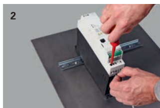
2 Připojit hlavní proudové vodiče.
